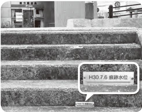
直方郵便局前河川敷の階段に設置してある痕跡水位プレート
